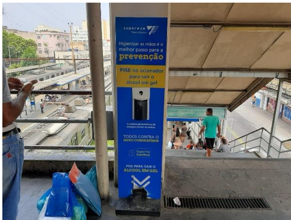
Figura 5.12 SuperVia - Estação Nova Iguaçu dia 03/10/2020
