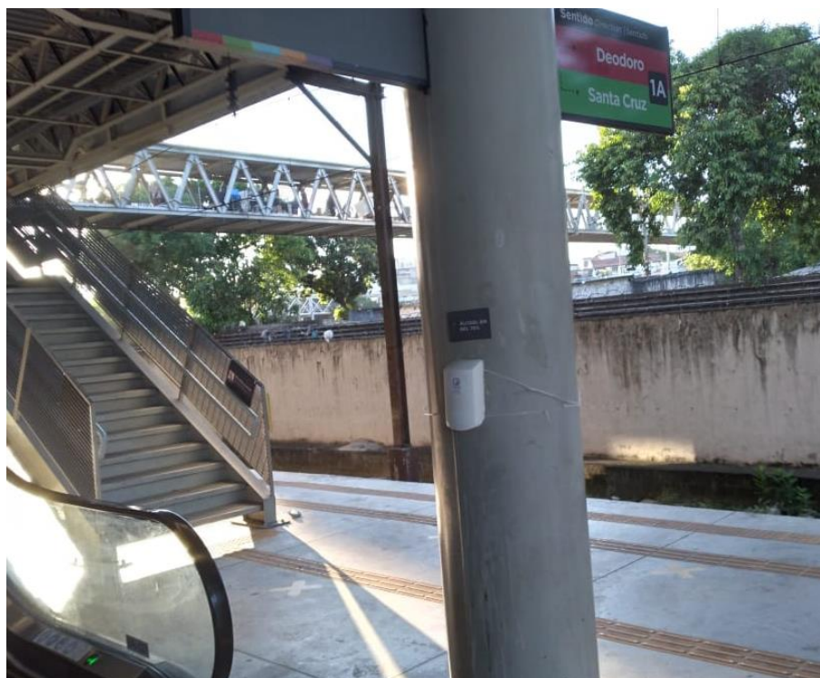
Figura 5.32 SuperVia - Estação São Cristóvão dia 23/10/2020
