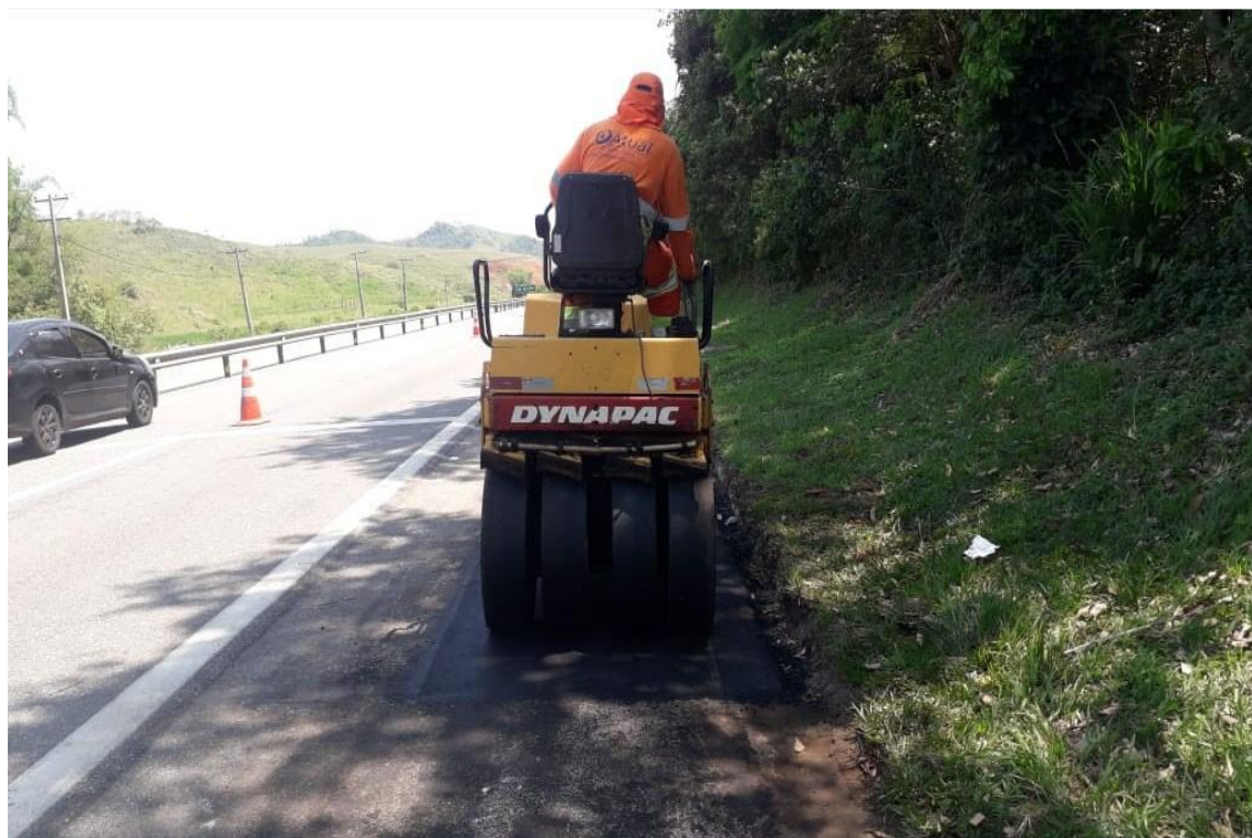
Figura 6.2 ViaLagos - Acostamento - Reparo Profundo - KM 7+500 Sul F2
