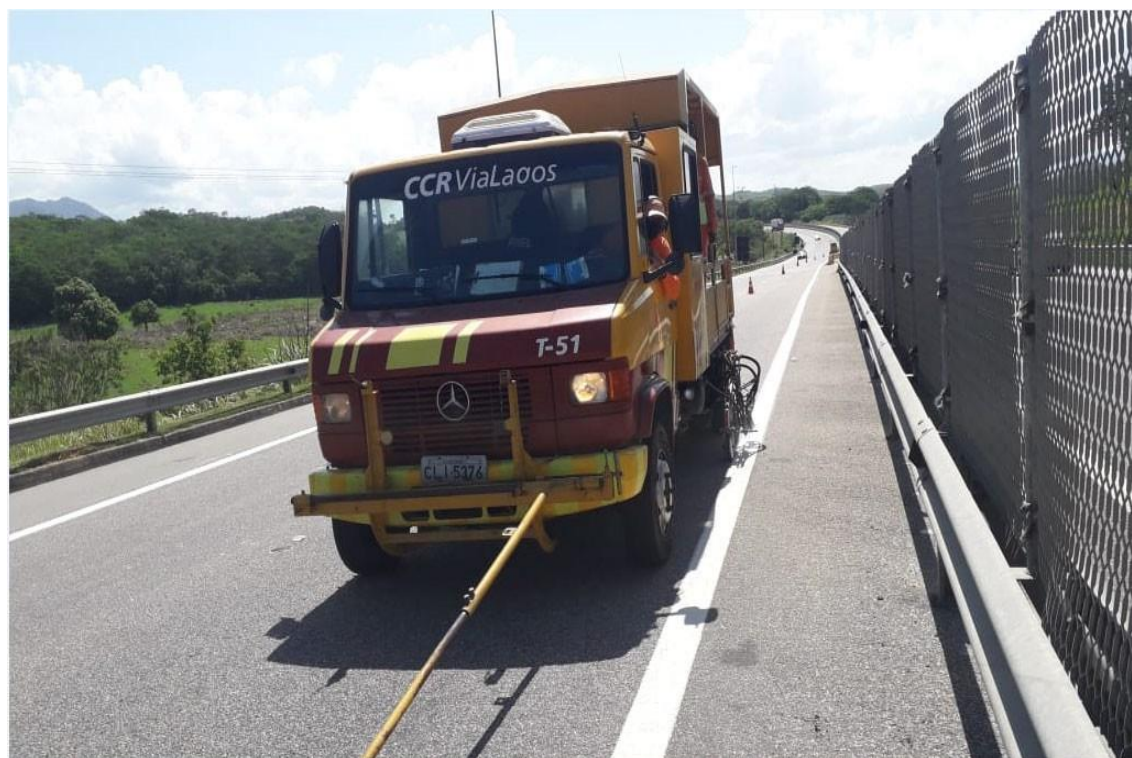
Figura 6.3 ViaLagos Pintura de Faixas - Km 27+000 Norte F3
